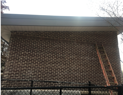
CSK- Metal Fascia/ Soffit Install
